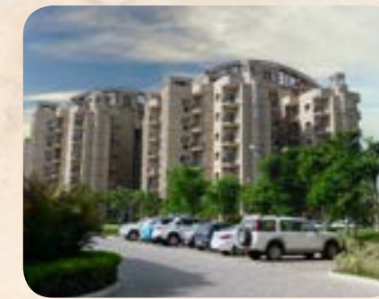
ATS PRELUDE Dera Bassi
